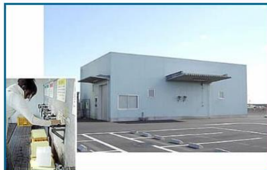
「焼津市駿河湾深層水脱塩施設」(市のWebサイトより)
